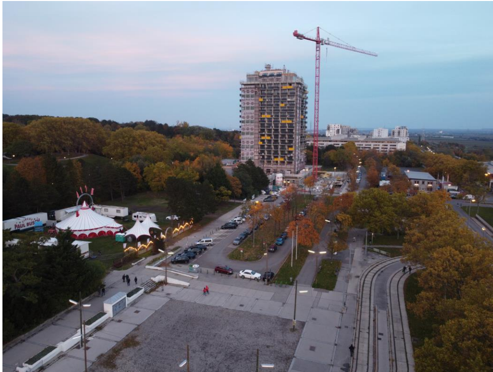
Abbildung 11: Projektfläche Kurbadstraße mit Blick auf den ehem. AIRO-Tower (Quelle: Knollconsult)
